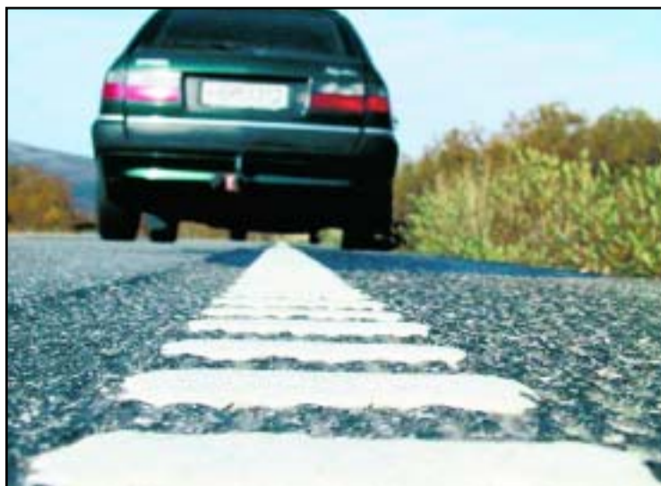
Statens vegvesen prøver nå å frese ned profilerte linjer i asfalten, slik at de ikke blir høvlet vekk av brøytebilen. (Foto: Morten Hafting)
